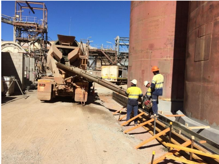
Photo7: Concrete pour for new leach bunds
