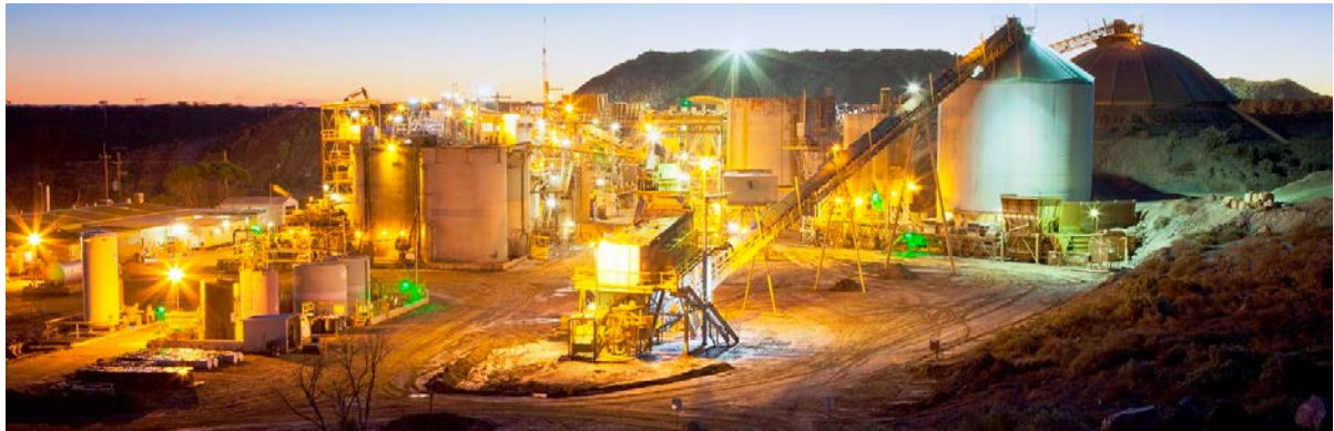
Jubilee Plant (SKO) 1.2 Mtpa
